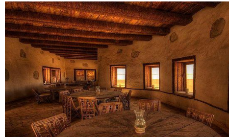
شكل (٢٥) استخدام جذوع النخيل في الأسقف الداخلية (٢٤)
