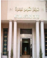
شكل (17) المدخل الرئيسي
