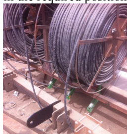
A:GR pipes reels
