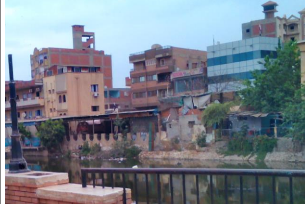
التعدى بالبناء على الجبهة المائية وتدهور المظهر العام لخلفية المباني المطلة عليها
