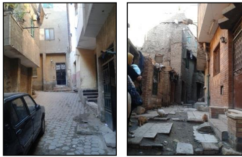
صورة (21) تواجد التبليطات في صورة متدهورة في حارة الشرافة وإختفاء اغلب التبليطات الأصلية، (تصوير الباحثة ) صورة (22) وجود تبليطات بحالة شبه جيدة في عطفة صيام، (تصوير الباحثة )
